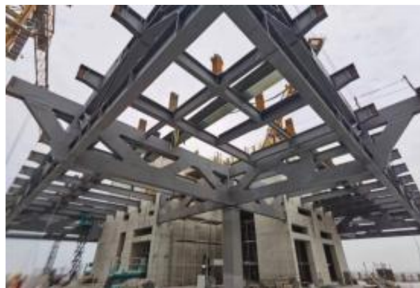
图2 塔冠施工完成现场照片
