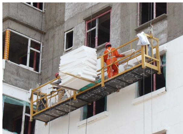
图1 绿色建筑外墙节能保温施工图
