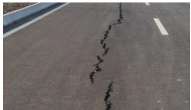
图1 纵向裂缝
