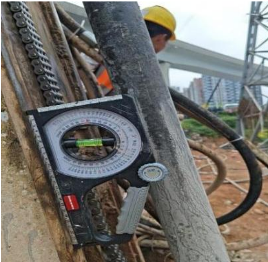
图3 多功能坡度测量仪器安装
