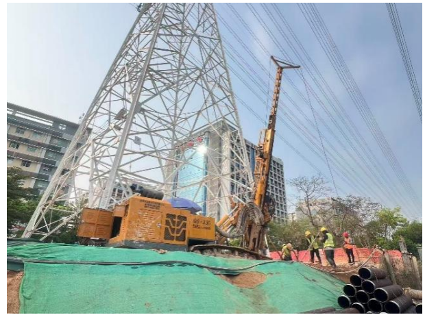
图5 微型钢管桩加固施工
