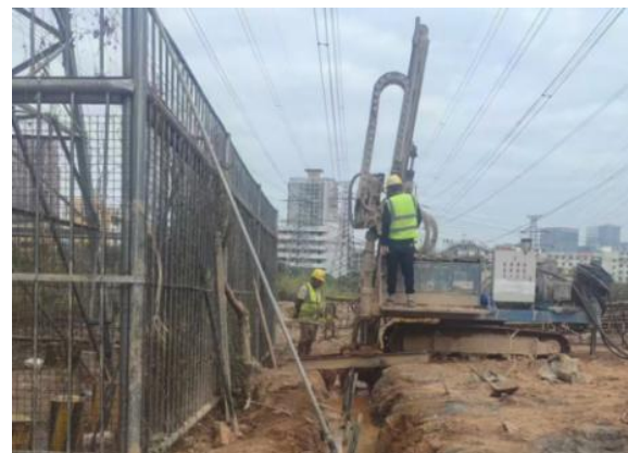
图2 袖阀管加固施工
