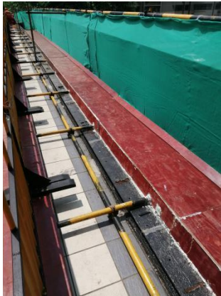
图 3.3-2 钢管脚手照片 1
