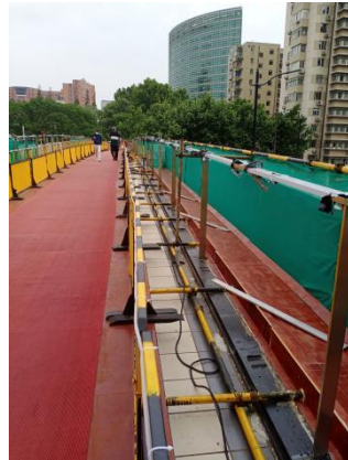
图 3.3-3 钢管脚手照片 2
