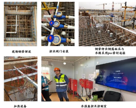
图 15 冷却水管现场安装示例
