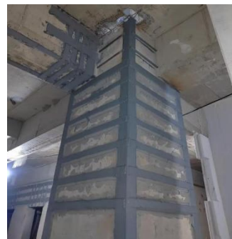
图1 外包型钢加固混凝土柱
