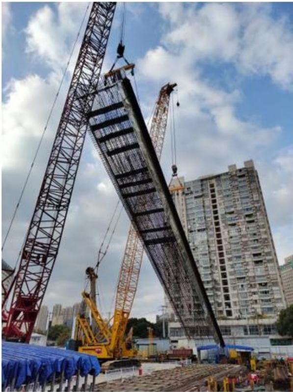
图9 钢筋吊装图 ←
