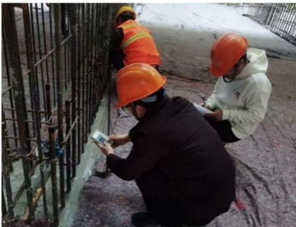
图12 底板混凝土测温
