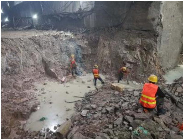
图1 矿山爆破后的现场清理作业
