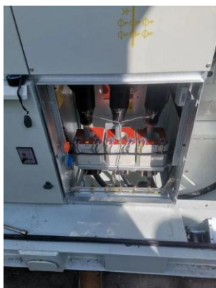
图1 电缆终端头施工工艺现场
