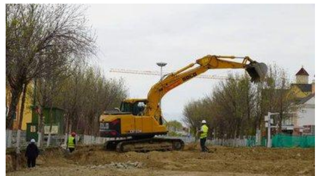
图1 市政道路工程隐蔽工程施工现场示意
