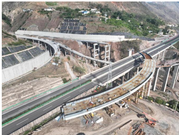
图 1 现场施工航拍图多点式顶推的整体布置
