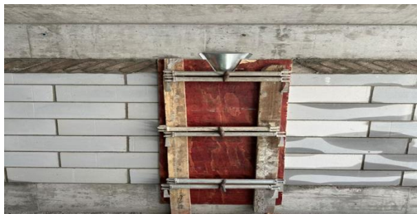
图 13 构造柱加固图
