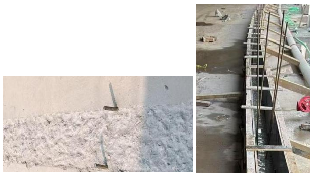
图 11 弧形反坎凿毛支模图
