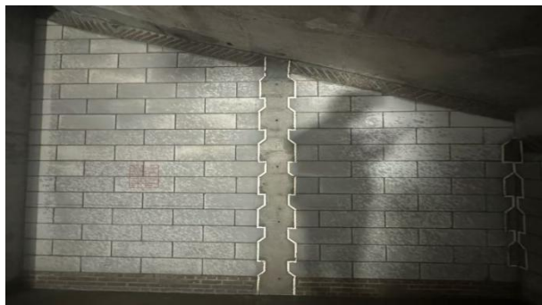
图 14 现场整体施工完成图
