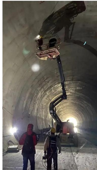
图1 隧道衬砌背后空洞检测作业现场
