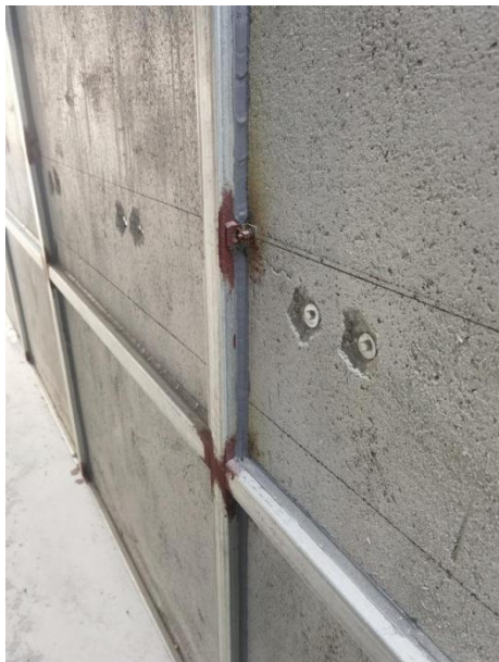
图4 对穿螺栓+焊接拘孺+B级背胶连接
