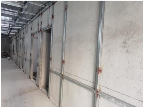
图3 50×20×2.0mm 不锈钢方钢龙骨安装
