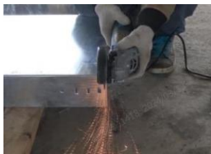
图10 桥架现场切割图
