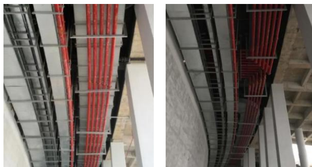
图 14 现场弧形管道安装效果 图 15 现场弧形管道安装效果
