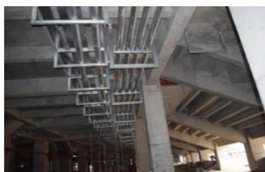
图 13 现场综合支架安装图
