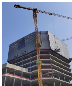
图 1 折线型结构外形建筑集成型全钢附着式升降脚手架实物图
