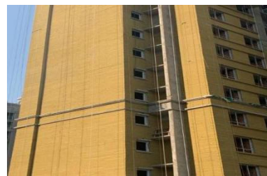
图 4 外墙岩棉施工效果
