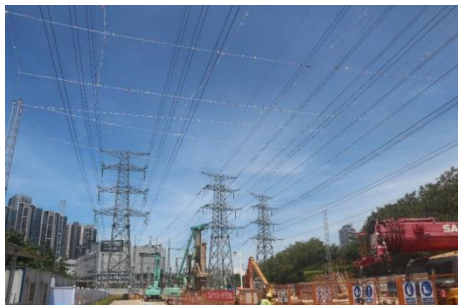
图 1 J6 工作井施工范围搭设防护网
