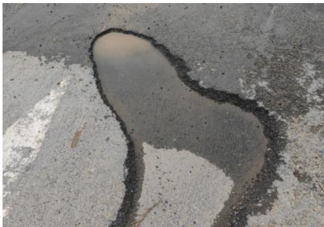
图3 路面坑槽
