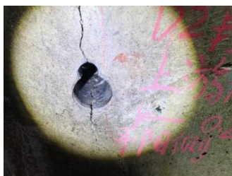
图 3-2 裂缝深度测量
