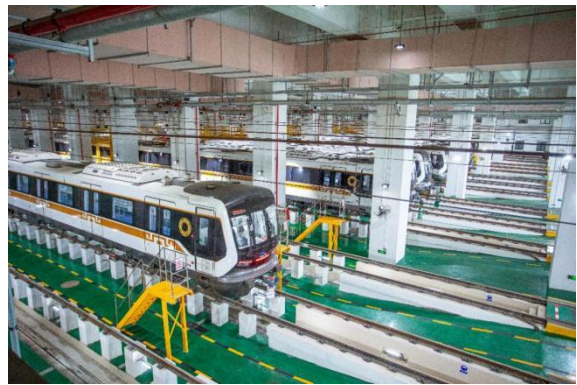
成都地铁6号线郫筒车辆段
