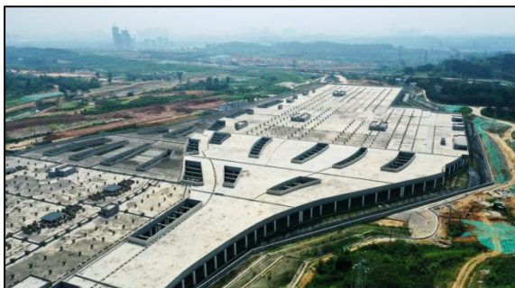
成都地铁5号线回龙停车场
