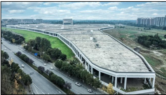
成都地铁6号线郫筒车辆段
