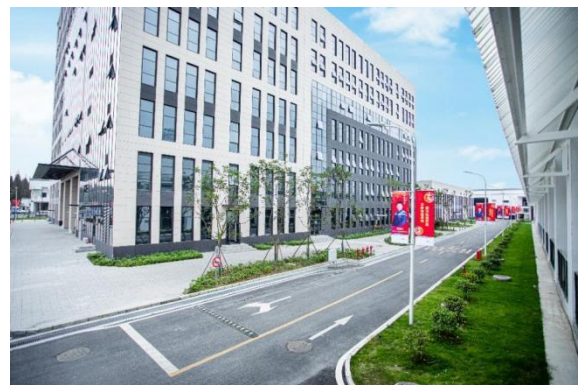
成都地铁6号线郫筒车辆段
