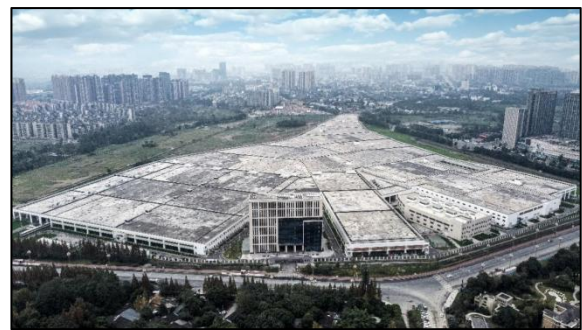
成都地铁6号线郫筒车辆段
