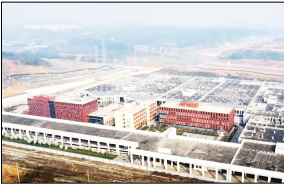
成都地铁5号线回龙停车场
