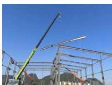
图1 钢结构吊装
