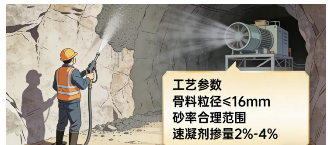
图1 喷射混凝土施工工艺优化图
