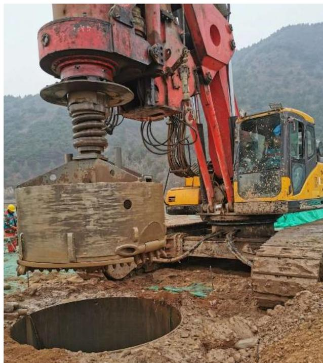
图1 旋挖钻机:一种高效的多功能打桩成孔机械
