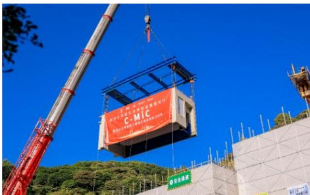
图 3 广州首单混凝土模块化集成装配式建筑试点项目启动“首吊”
