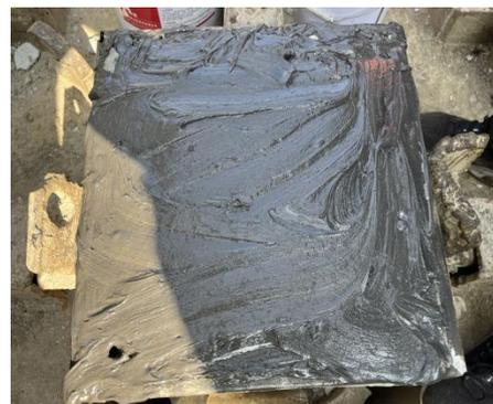
图5 涂抹防腐密封材料
