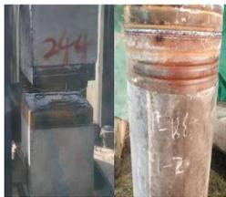
图1 弹卡式连接预应力混凝土方桩施工图 图2 先张法预应力混凝土管桩施工
