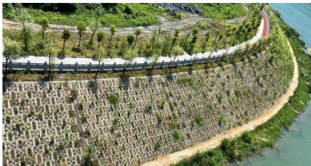
图1 生态护坡:守护河流的绿色防线
