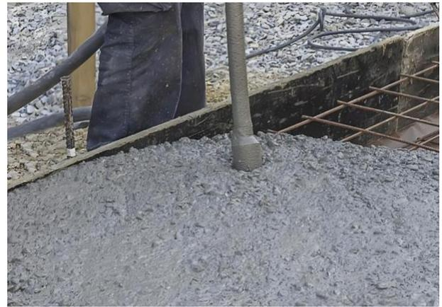
图1 混凝土振捣作业现场及振动信号来源环境
