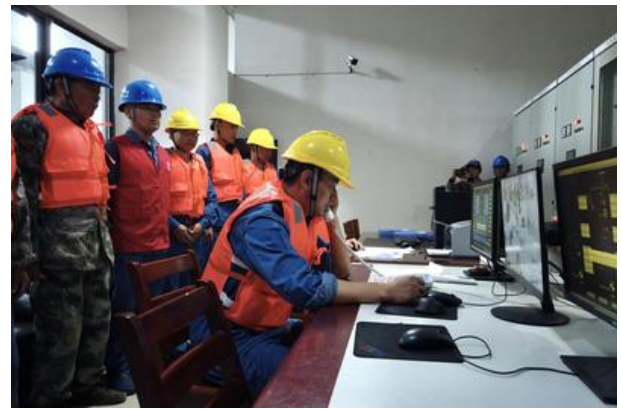
图1 水电站防汛期间中控室运行监控与值守
