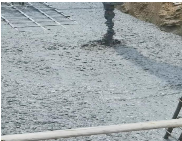
图2 建筑工程混凝土振捣作业现场
