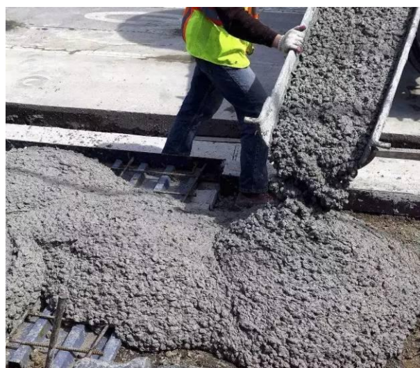
图1 混凝土浇筑施工现场作业图
