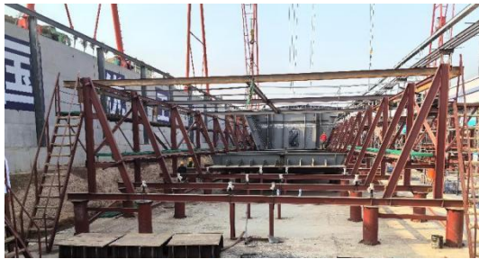
图 4 槽型梁自动对位拼装胎架示意图
