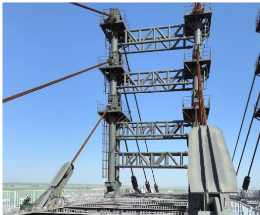
图 5 吊索塔架辅助顶推施工技术图
