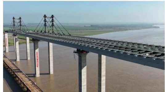
图 6 多台步履式顶推设备同步施工图
