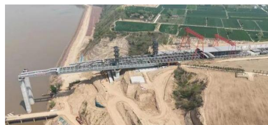
图3 钢梁顶推施工实景图
