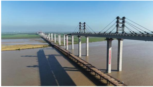
图8 现场顶推示意图
