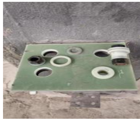
图 2 檩托板处绝缘垫块以及绝缘套管、螺栓
