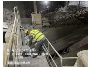
搅拌站内掺渗透结晶
