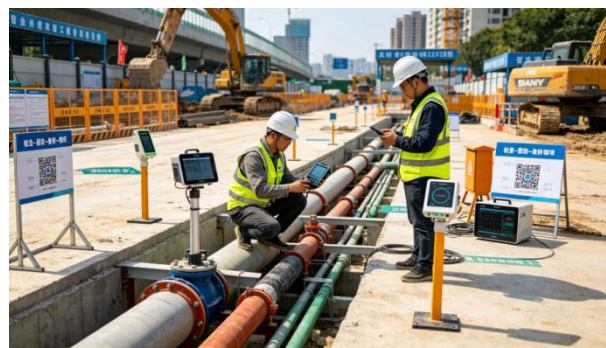
图1 管网智能巡检现场作业
