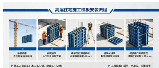
图1 模板安装流程设计图
