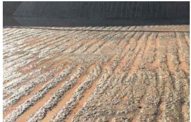
图1 灌浆盖板凿毛工作参考图
