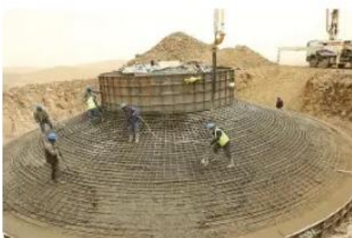
图 1 风电机组基础混凝土浇筑施工现场
