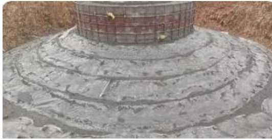
图2 风电机组基础混凝土冷缝现场图示
