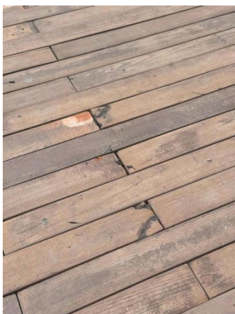
图 2 架空混凝土仿木栈道严重破损照片
