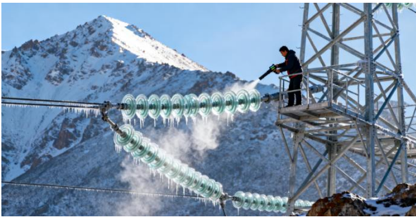
图1 西藏高海拔地区特高压线路合成绝缘子及带电融冰作业示意图
