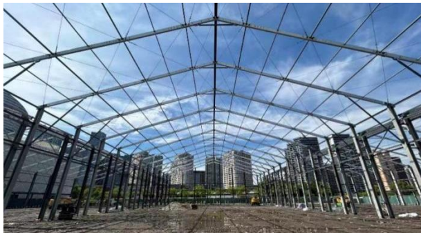
标准铝梁施工照片
