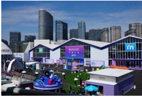
项目建成照片
