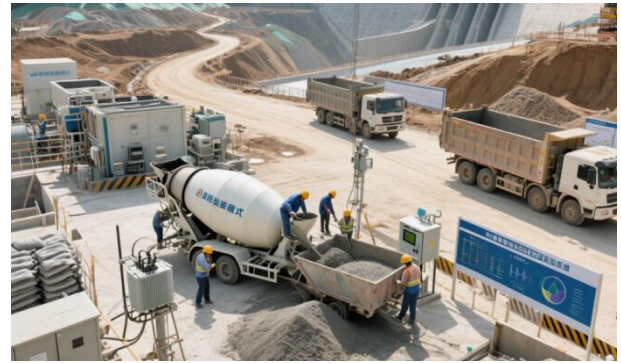
图 1 绿色理念下的水利水电施工现场
