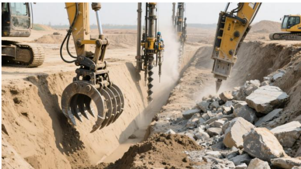
图1 不同地层下的成槽设备施工
