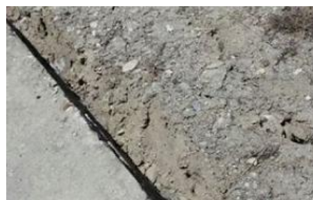
图 1 堤防裂缝示意图
