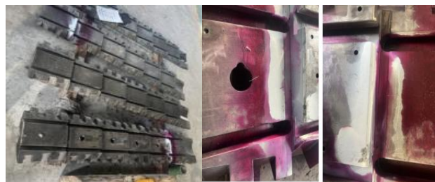
图2 扇形板变形开裂照片
