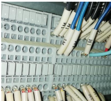
图2 X5端子排的18号端子松动
