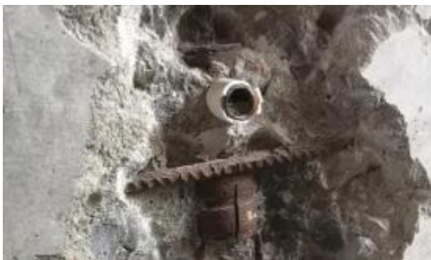
图1 套筒灌浆内部空洞缺陷示意图
