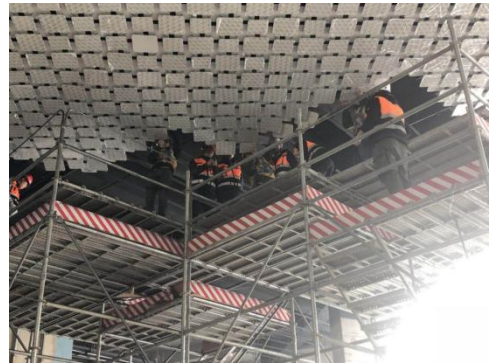
图3 双层铝片组件化安装
