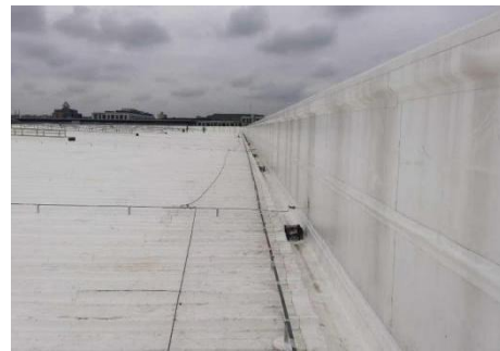
图4 屋面天沟及女儿墙翻新处理
