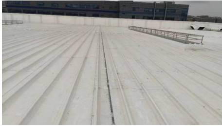
图6 屋面满粘施工效果
