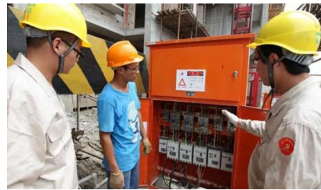
图2 施工现场临时用电安全讲解
